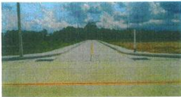
รายละเอียด ถนน ค.ส.ล. เขตทางกว้าง ๙ เมตร เขตทางยาว ๘๓๐ เมตร
